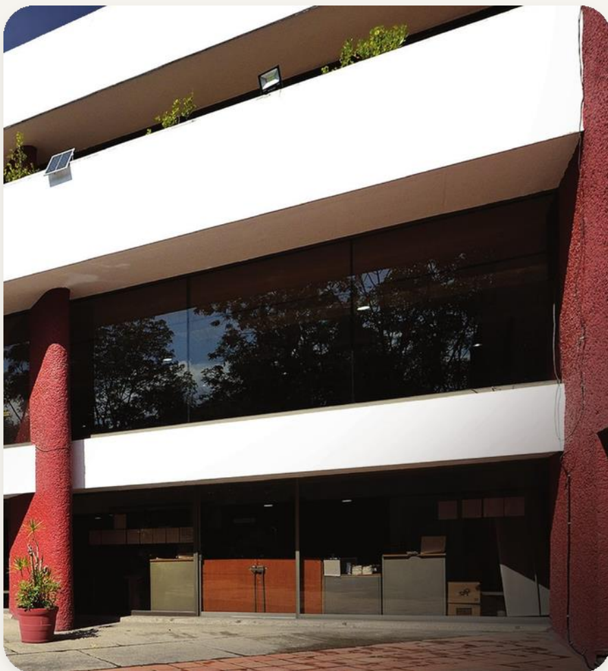
Fachada sobre Periférico Sur
